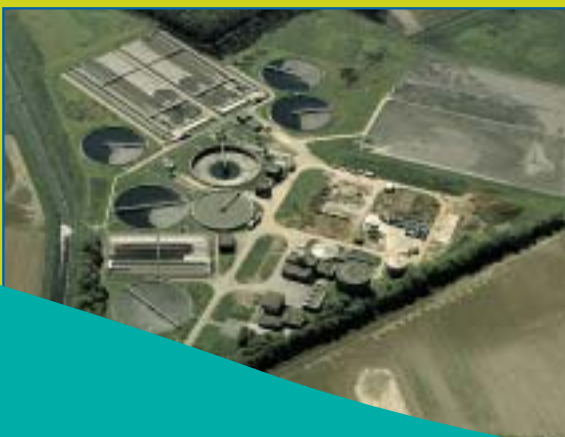
• Rioolwaterzuiveringsinstallatie Susteren (Foto: Airphoto Netten, Maastricht)
