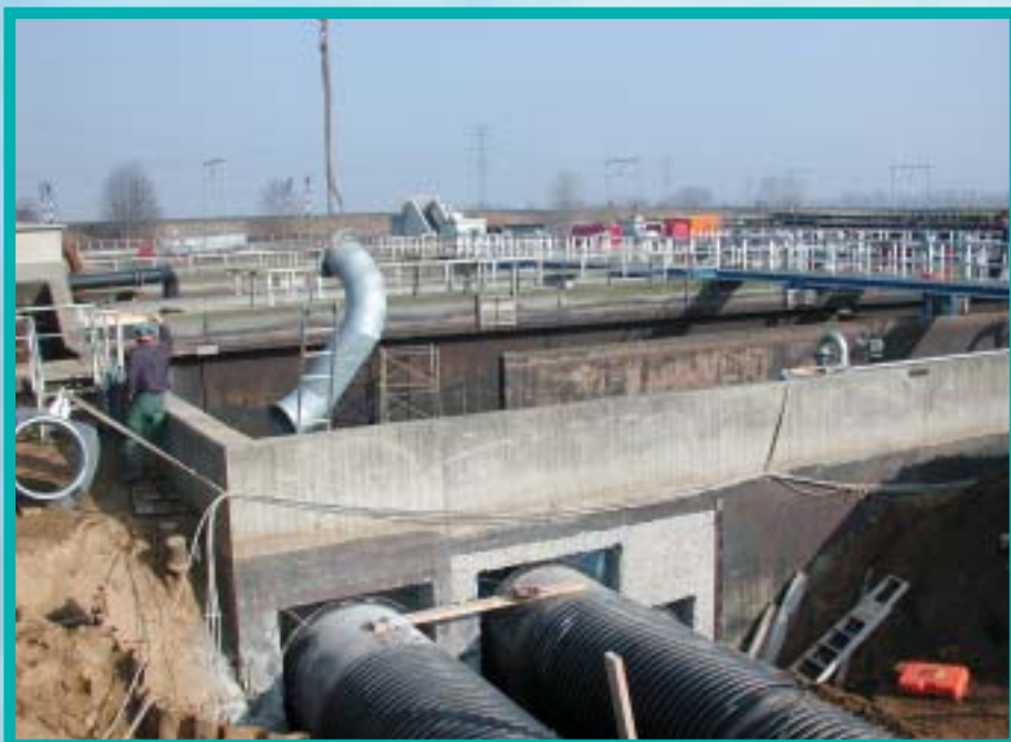
• Fikse uitbreiding zuiveringsinstallatie Roermond.
